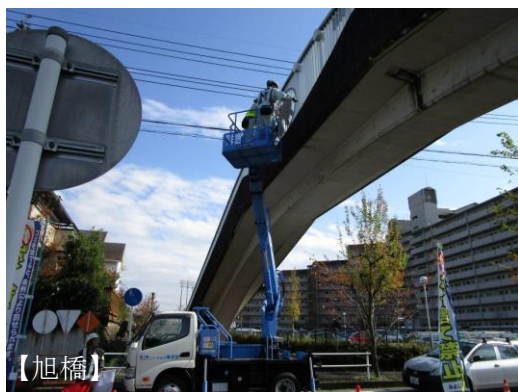
写真-3.1 専門業者による点検状況①
