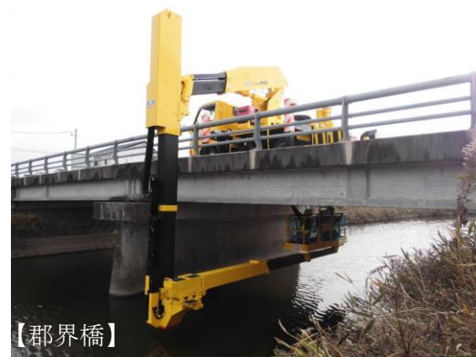
写真-3.2 専門業者による点検状況②
