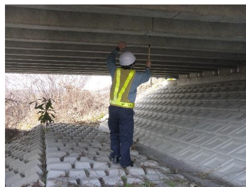
写真-3.4 職員による点検状況②
