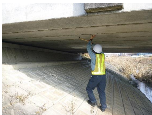
写真-3.3 職員による点検状況①
