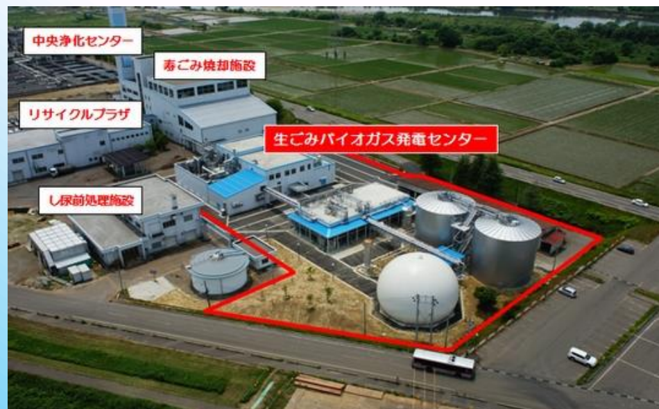
バイオマス発電センター全景
