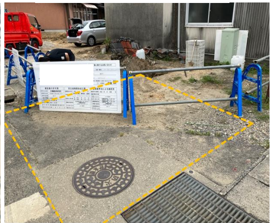
既設防火水槽
