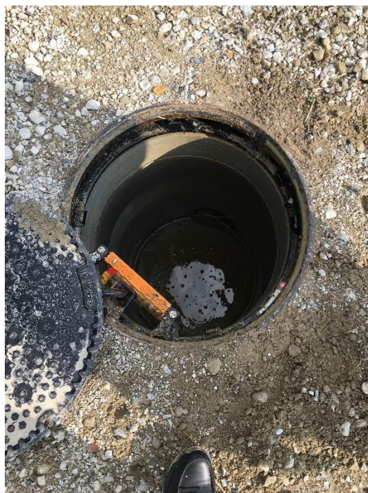
写真 4.2 MHR130-1 施工状況
