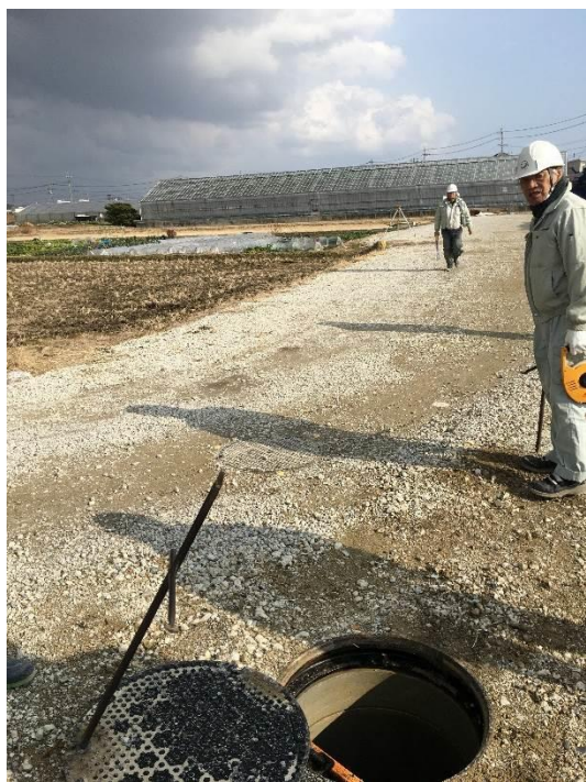
写真 4.1 管路布設後埋戻状況
