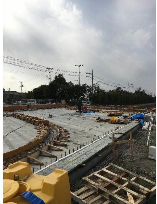
写真 4.2 橋面施工状況
