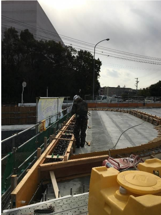
写真 4.1 地覆鉄筋・型枠施工状況
