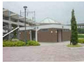
駅前広場に設置されたトイレ (愛環梅坪駅)
