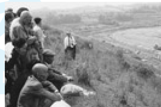
陸上競技場の工事見学
