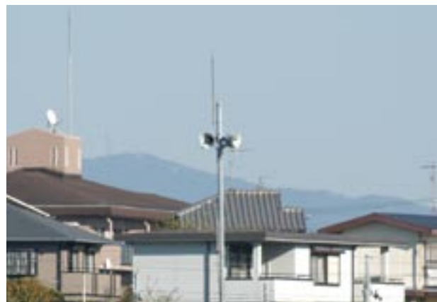
サイレンで始まる放送は非常事態の内容です
