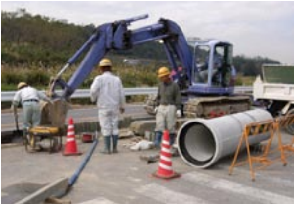
福谷～黒笹地内で行われている下水道本管埋設工事
