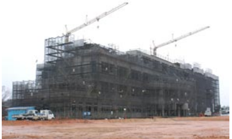
建設が進む三好丘中学校
