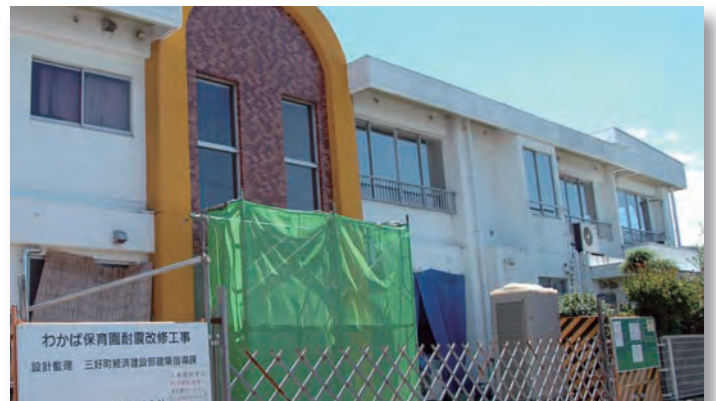
昨年の耐震診断に基づき、今年度耐震補強工事を実施している三好町立わかば保育園
