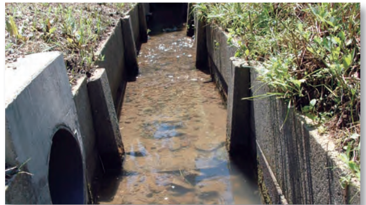
平池地区の北側に位置する東郷町との境となる土地改良区の排水路
