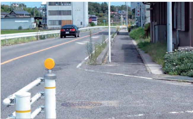
安全対策として今年度中にガードパイプが設置される予定の町道明知新屋線の明知上地内
