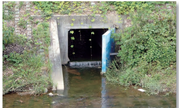
境川に放流される農業用排水路。間口1.8m、高さ1.5m
