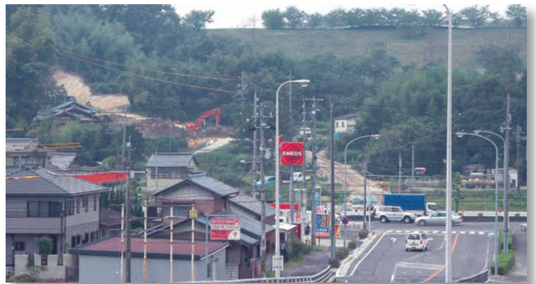
東名三好インターに向けて土取り作業が行われている 主要地方道路豊田知立線福谷宮の前交差点西側
