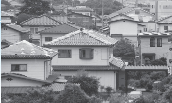
▲震源地に近づくにつれて、瓦ぶきの棟が落ちている家屋があちらこちらに見られるようになってきます(仙台市)
