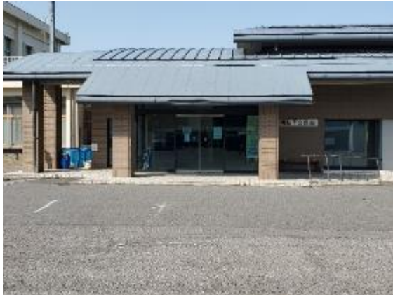
明知下公民館出入口庇修繕
