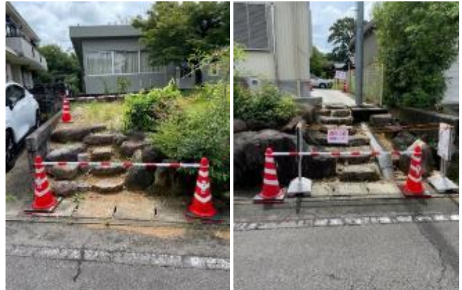
高嶺公民館石階段改修
