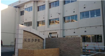
市内各校の校舎の建設・改修の状況
