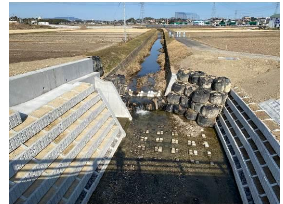
整備が進む準用河川の改修（茶屋川）
