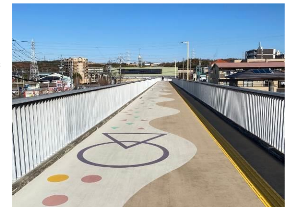
「橋梁長寿命化修繕計画」に基づき修繕を終えた橋梁
