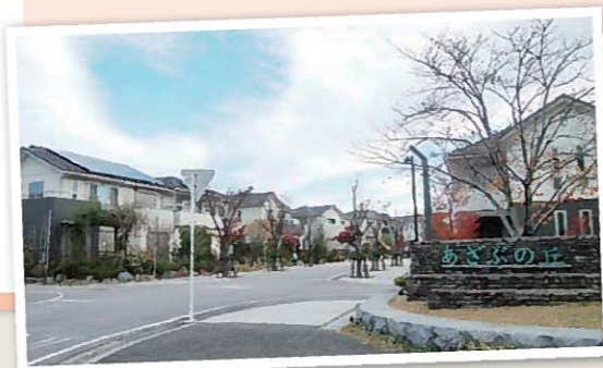
整然と立ち並ぶ住宅地▶
