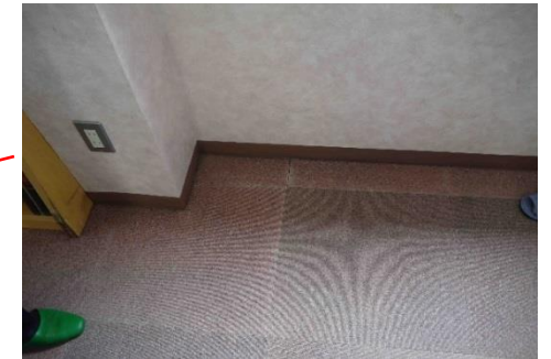
図書コーナー床 図書コーナー床に雨漏りの跡が見られます。
