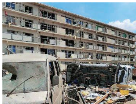
竜巻による被害
