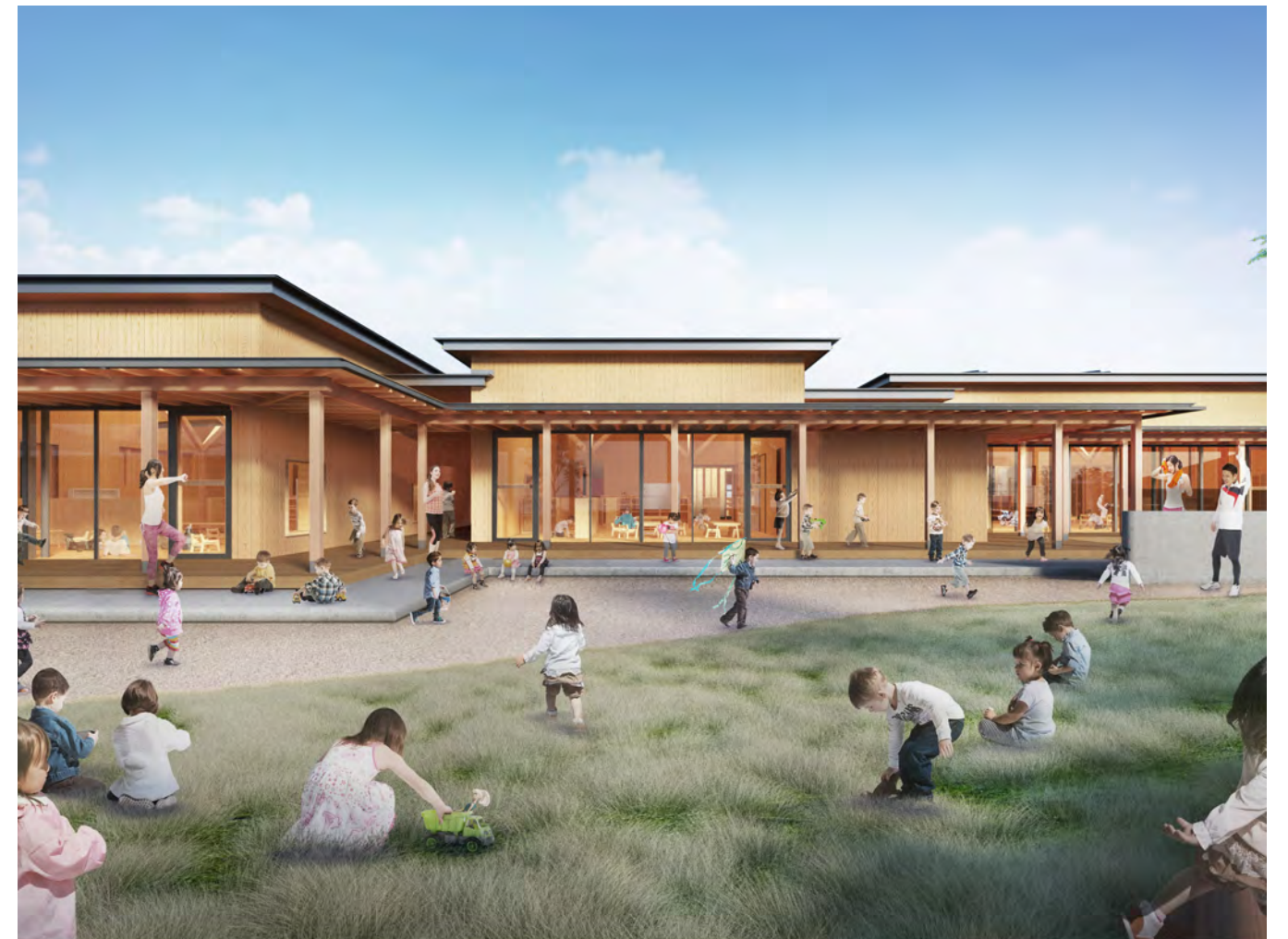
南側園庭から見た建物
