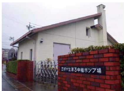
三好ヶ丘第3中継ポンプ場
