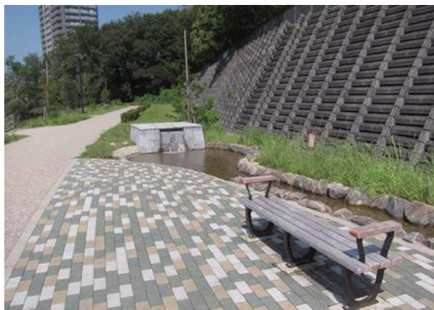
整備事例（三好丘5丁目付近）
