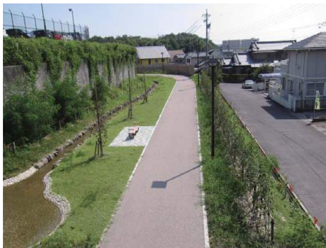
整備事例（三好丘6丁目付近）
