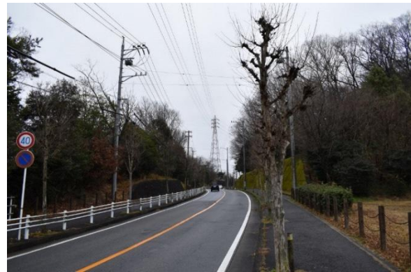
森の連続性の確保が望まれる道路
