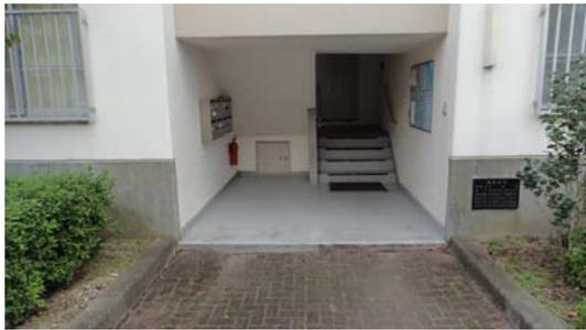
※駐車場、遊び場からはスロープが設置されているが、階段室の入口に段差がある。
