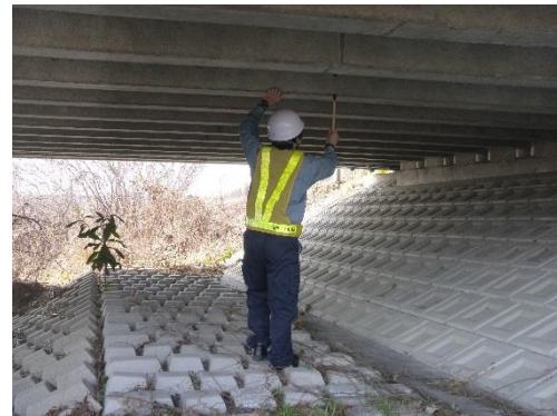
写真-3.4 職員による点検状況②
