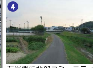
左岸側に北部コミュニティ広場が整備されている。
