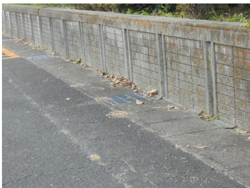
敷地南側の土留め壁
