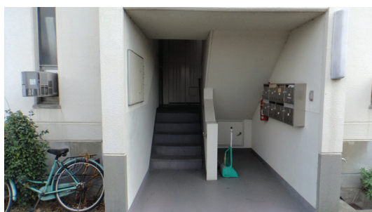
バリアフリー改修前の階段入口
