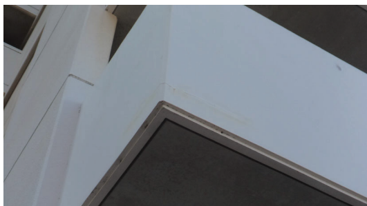
階段回り外壁
