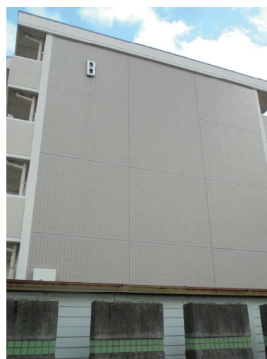
B棟：妻側外壁
