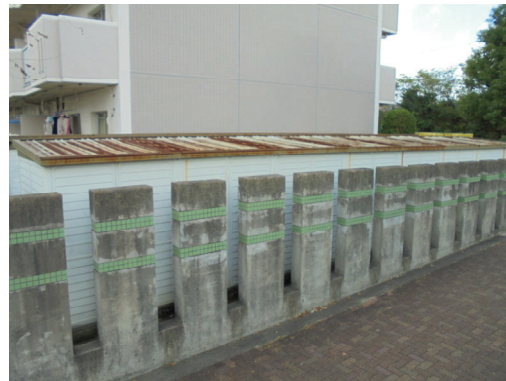
物置（屋根一面に錆が拡がり、劣化が確認できる）
