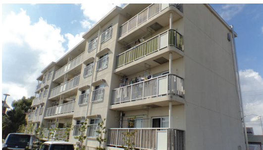
A棟：東南面
