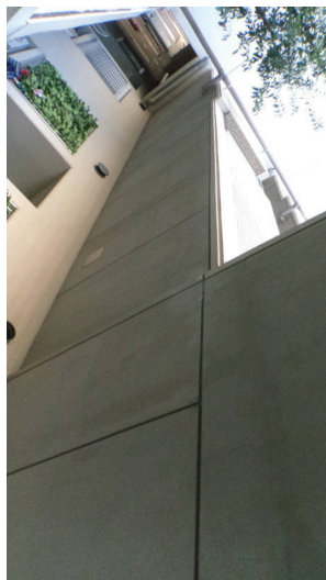
外壁入隅部分
