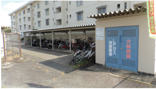
駐輪場（C棟前）
