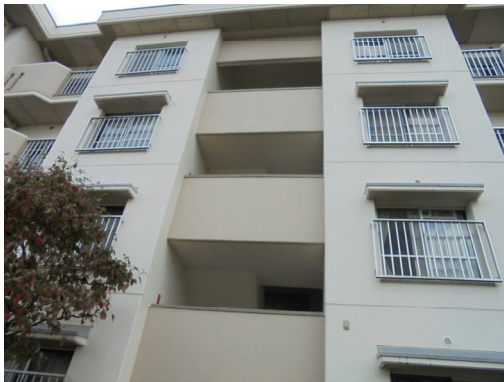
北側階段回り外壁
