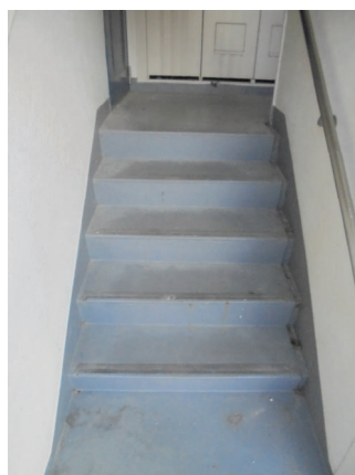
バリアフリー改修前の階段
