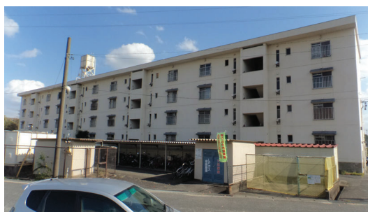
C棟：北面（バリアフリー改修前）
