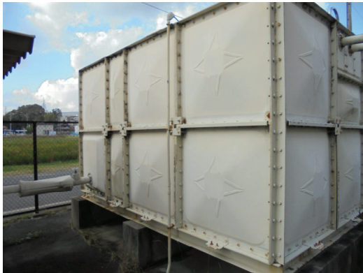
給水タンク（損傷、劣化は見られない）
