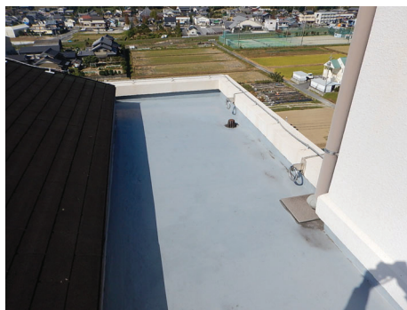
屋上・屋根（8階建住棟）
