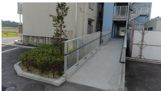
バリアフリー改修後の入口スロープ（A棟）
