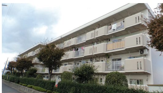
B棟：南側全景
