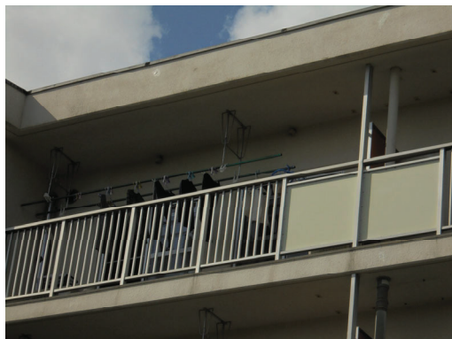
南面ベランダ（損傷・劣化は見られない）
