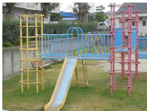
遊具（塗装の劣化がみられる）
