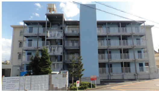
A棟：北面（バリアフリー改修済）
