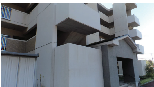
エントランス付近
