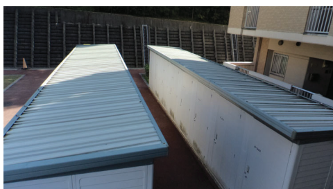
物置（汚れはあるが、損傷・劣化は見られない）
