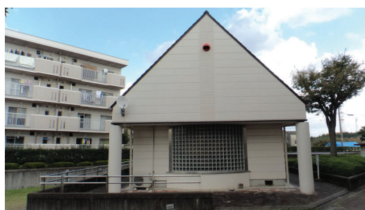
特に損傷、劣化は見られない。
