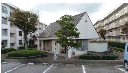
中庭に設置された集会所
