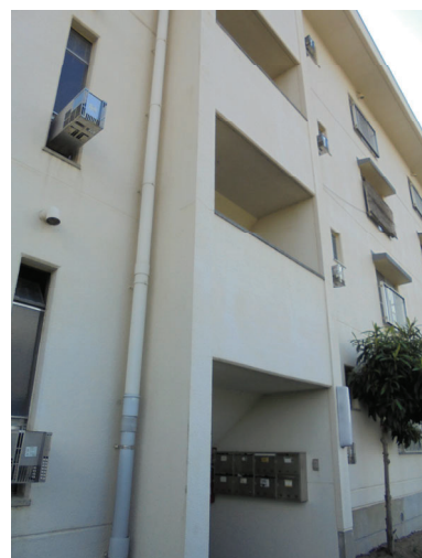
北面：階段入口
