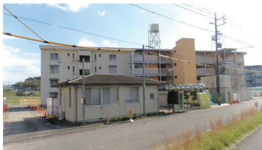
B棟：北面（バリアフリー改修中）
