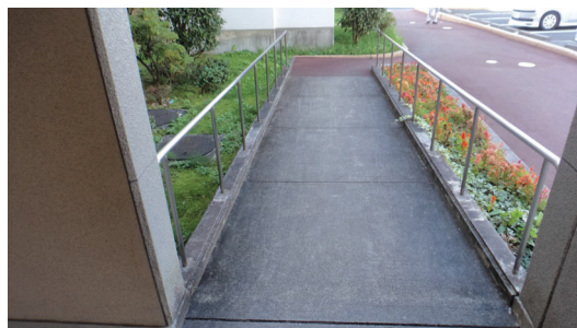
エントランス部分のスロープ設置済み
