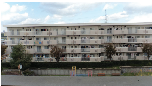
A棟：南側全景
