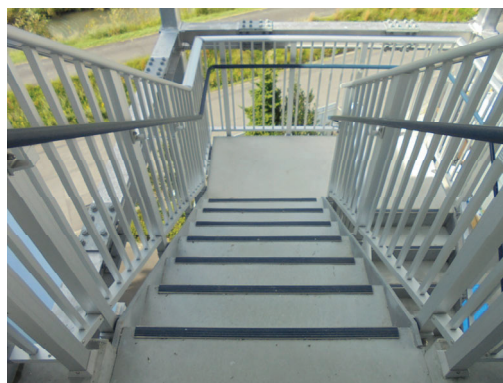
バリアフリー改修後の階段
