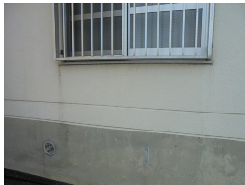
北面窓回り（基礎部分に補修跡あり）
