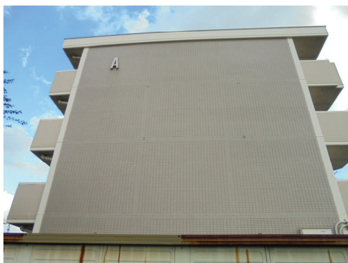
A棟：妻側外壁
