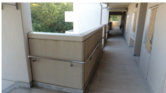
通路には手摺設置済み
