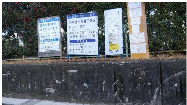
写真－2 工事標示看板 設置状況
