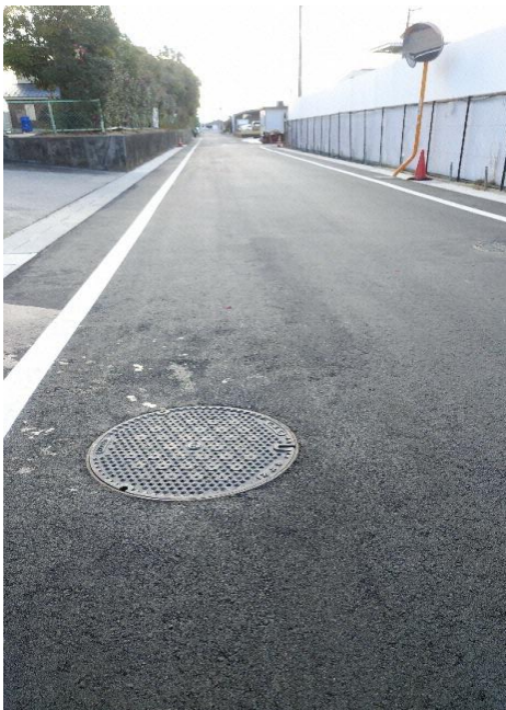
写真－1 工事現場（全景）
