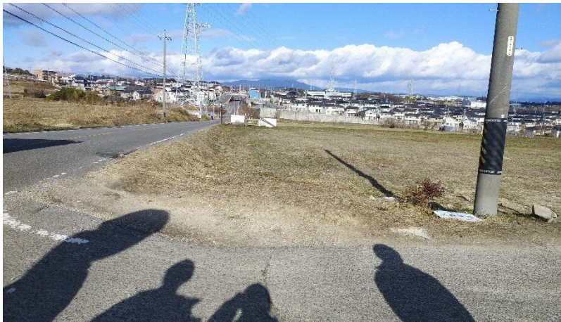
写真－1 工事現場（全景）
