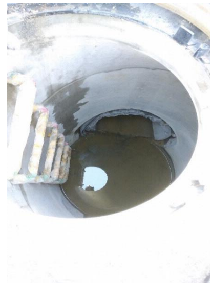
写真－4 工事現場（組立2号人孔）
