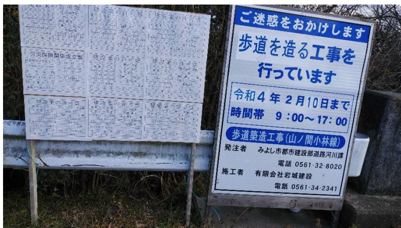
写真－3 工事標示看板設置状況
