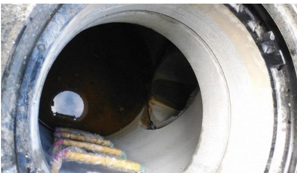
写真－3 工事現場（組立3号人孔）
