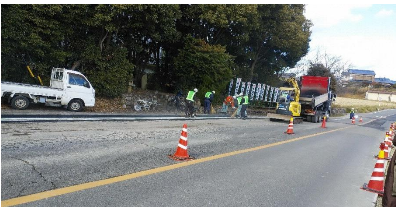
写真－4 工事現場（工事实施状況）
