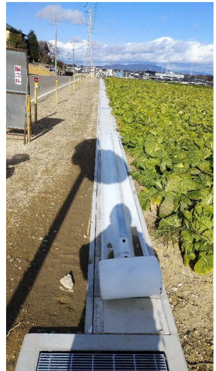
写真－2 工事現場 （歩道部拡幅工，側溝工）
