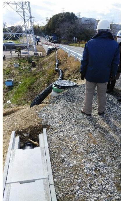
写真－5 工事現場 （法面整形工他）
