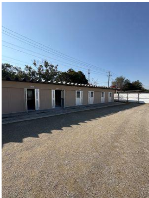
写真-9 工事現場施工状況 (クラブハウス化改修工事)
