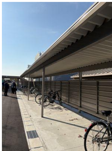
写真-10 工事現場施工状況 (自転車置場新設工事)
