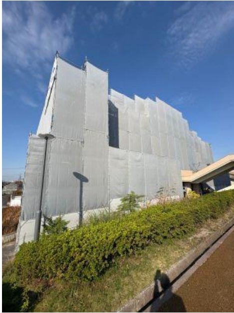
写真-5 工事現場施工状況 (屋内運動場外壁改修工事)
