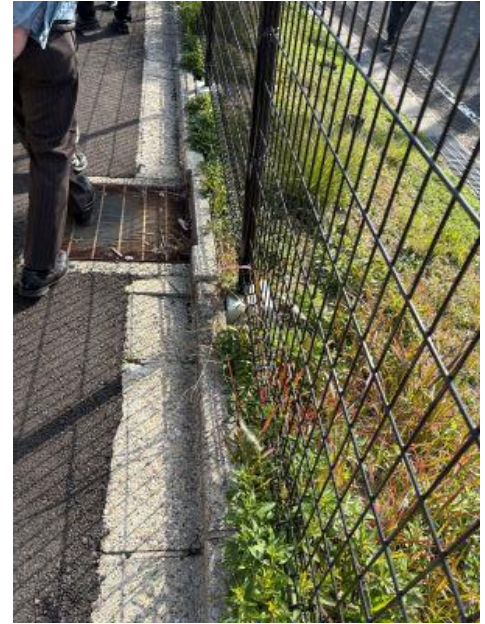
写真-8 工事現場施工状況 (職員駐車場改修工事)
