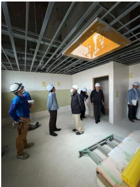
写真-7 工事現場施工状況 (屋内運動場更衣室改修工事)
