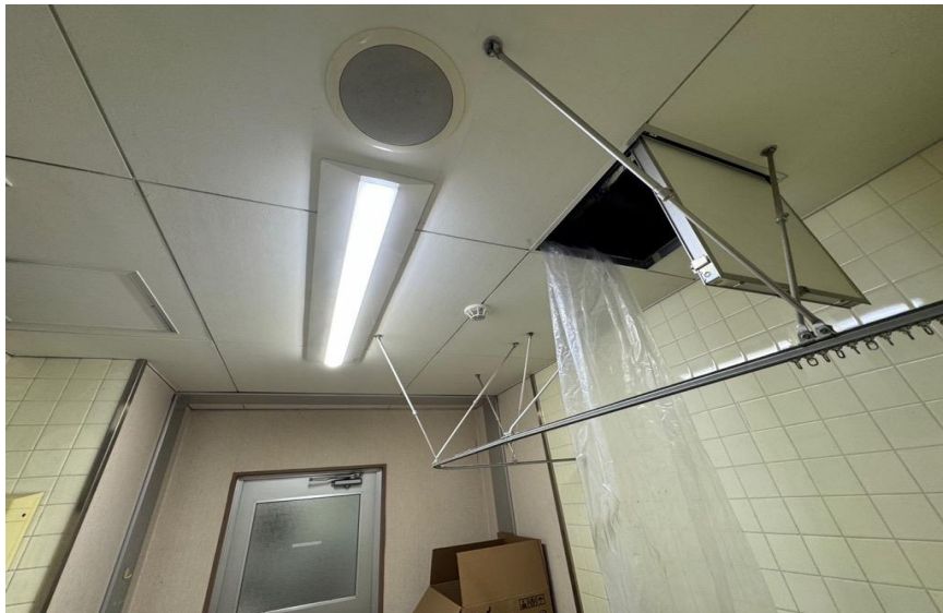
障がい者福祉センターリネン室天井
