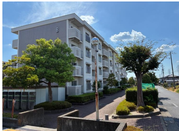
改修前現況(B棟)
