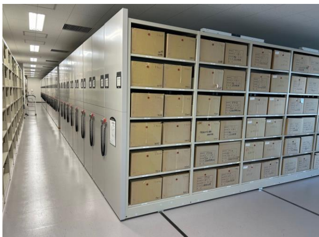
庁舎文書保管センター(庁舎4階北側)
