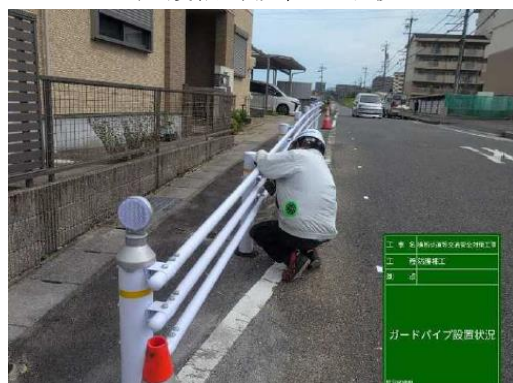
ガードパイプ設置状況
