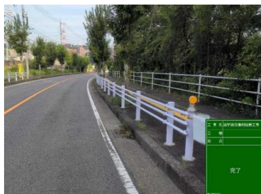
防護柵等設置工事後
