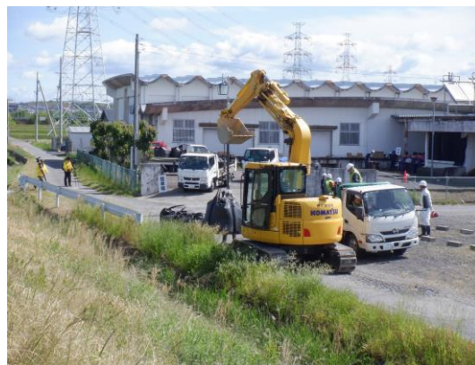
大型土のう設置訓練
