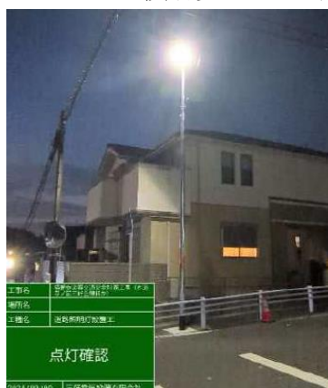
道路照明灯設置後
