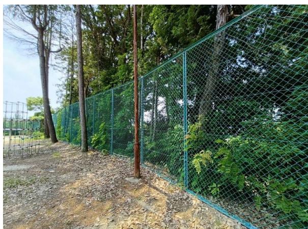
《苅生農村公園》更新後のフェンス
