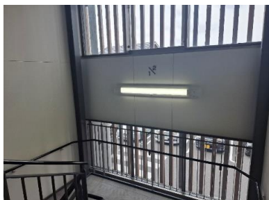
階段照明修繕
