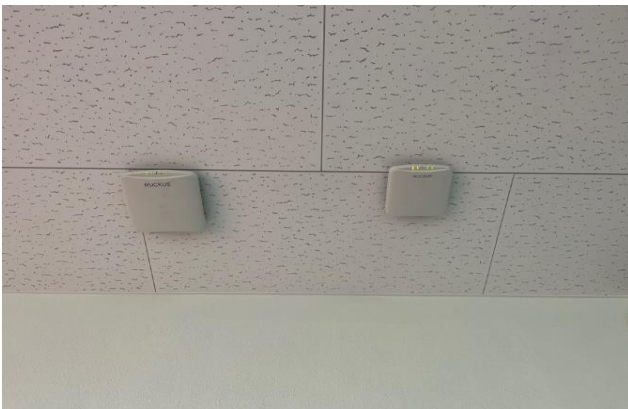
三好公園総合体育館公衆Wi-Fi導入工事
