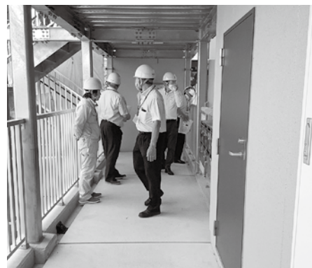
◎助生住宅大規模改修（3期）工事
