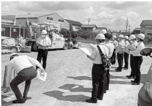
◎新リサイクルステーション建設工事
