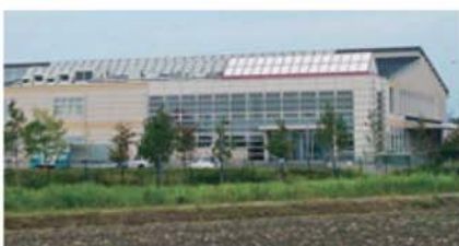
●給食センター太陽光発電装置
