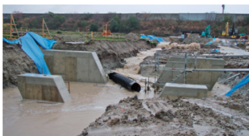
●砂後川河川改修工事 (肋生地内)
