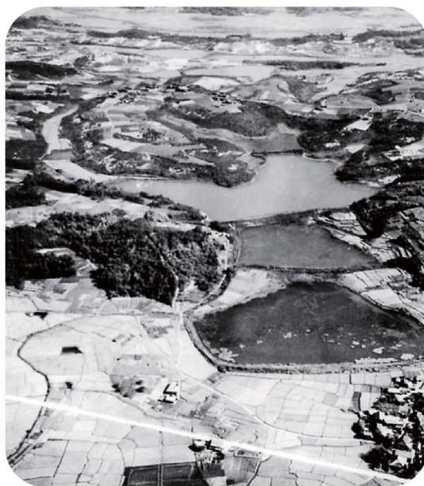
三好池竣工前の曲がり池
