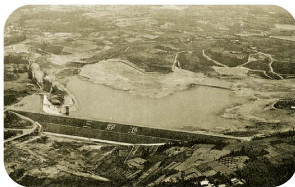
三好池完成(昭和34年3月)
