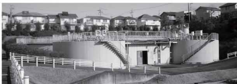
●三好ヶ丘浄化センター
