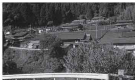
●ダム移転により水没する大名倉集落
