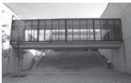
◎黒笹小学校渡り廊下
