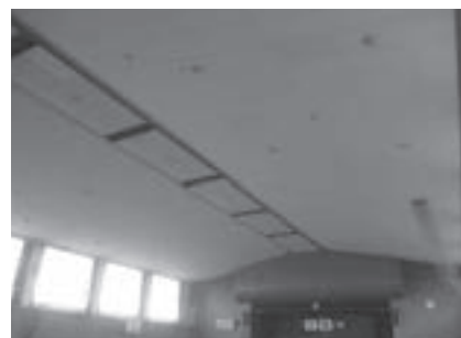
◎南中学校体育館天井
