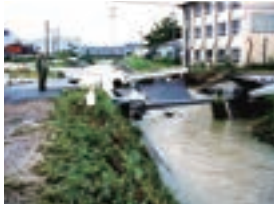
(崩落した木之本橋)
