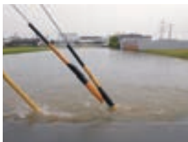
(一面が冠水した西一色地区の 境川沿い)
