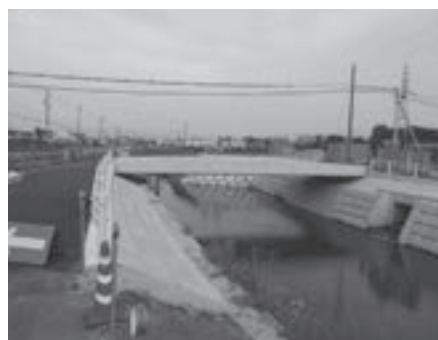
◎茶屋川改修工事
