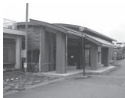
◎明知下公民館外壁補修工事
