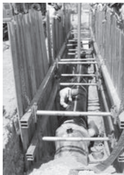
◎地震に強い水道管の布設工事
