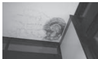
◎緑と花のセンター（修繕箇所）
