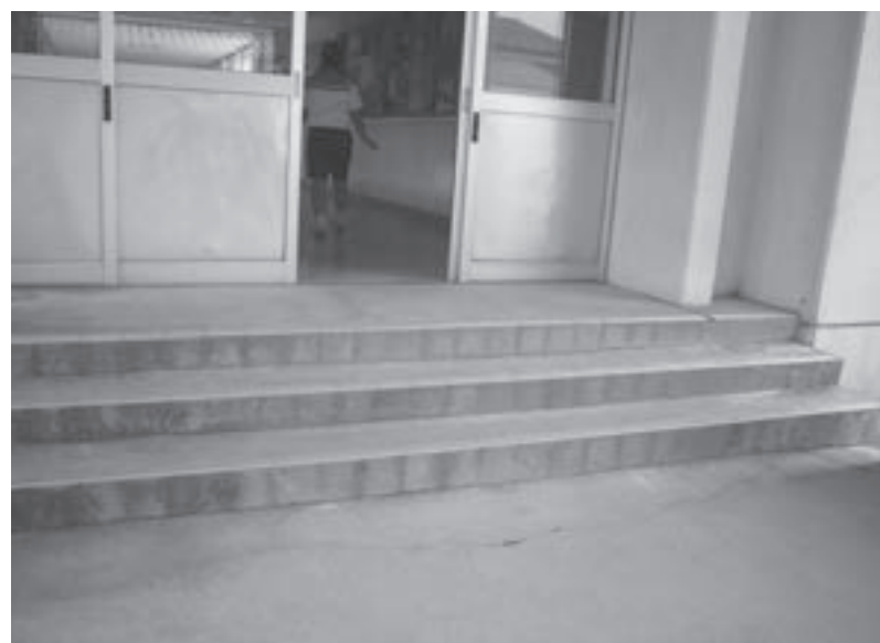
◎北中学校（バリアフリー改修箇所）
