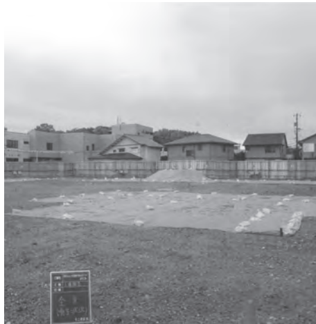
◎（仮称）図書館学習交流プラザ 応急措置実施箇所
