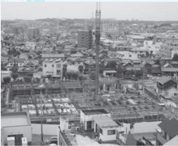
◎(仮)図書館学習交流プラザ工事 6月22日撮影
