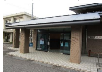
入口上庇修繕工事(明知下行政区)
