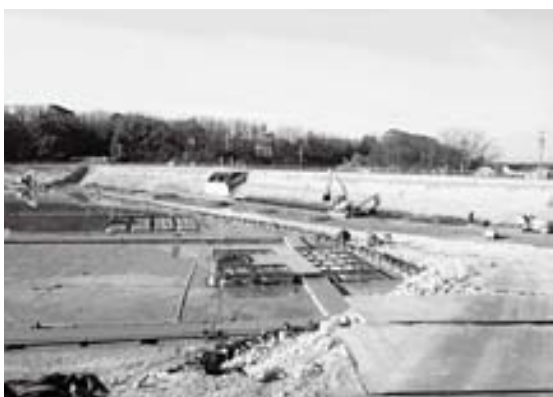
◎保田ヶ池堤体補強工事
