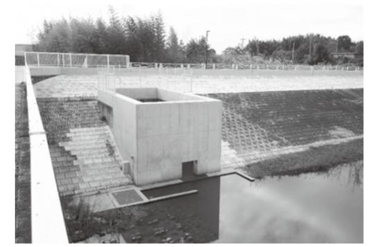
◎堤体の高上げ・排水調整機能の完成した調整池
