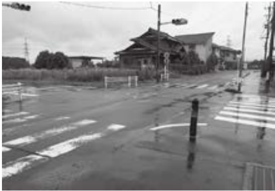
◎防護柵の設置が望まれる交差点
