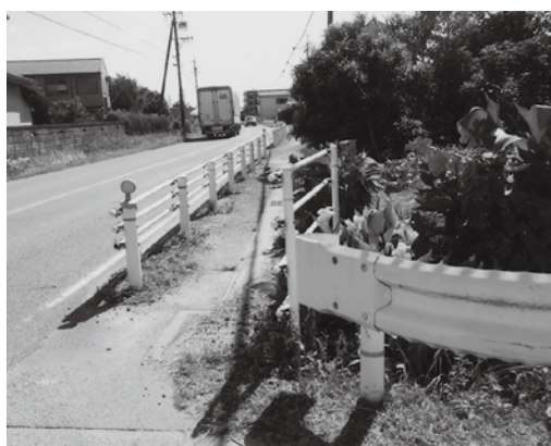
◎ガードパイプ
