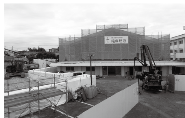
◎三吉小学校大規模改修工事
