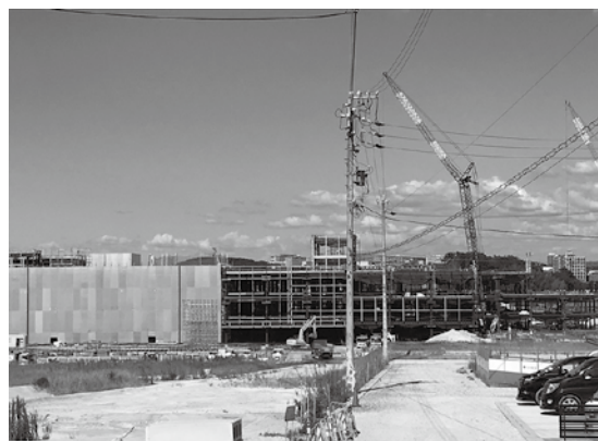
◎東郷町に建設中の大型商業施設
