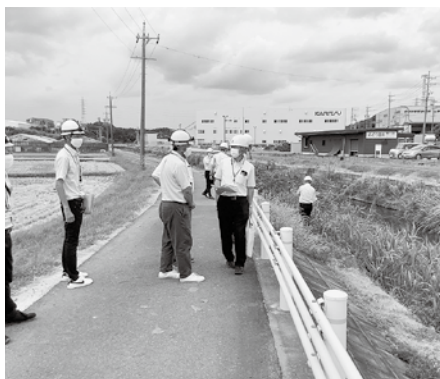
◎茶屋川浚渫工事
