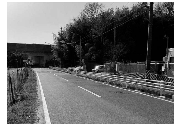
◎歩道部にガードパイプ設置
