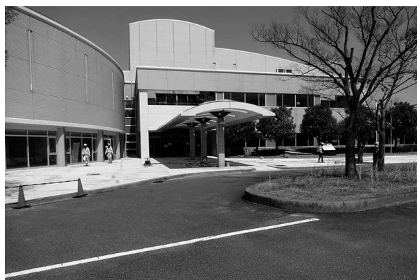
◎サンアート大規模改修工事
