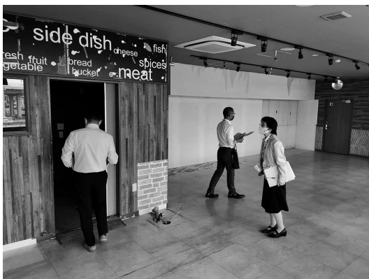
◎カリヨンハウス2階改修予定エリア
