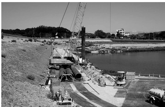
◎三好池耐震補強工事 (2020.9.28)
